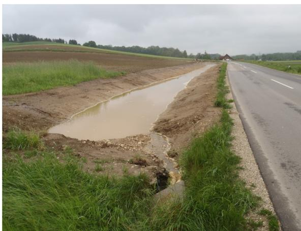
In den ersten Bauabschnitt wurde der Höhenrückens in Ampfenham Richtung Ramerding einbezogen. Mit dem Bau von entsprechend dimensionierten Retentionsbecken
